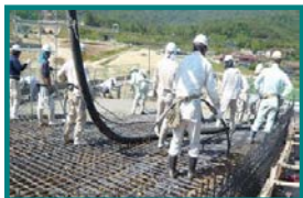
①コンクリート打設
