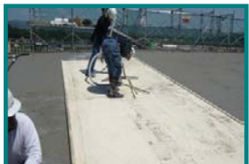
⑤真空脱水BF処理
